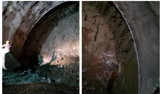
Slika 4. i 5. Montiranje armaturne mreže 4
