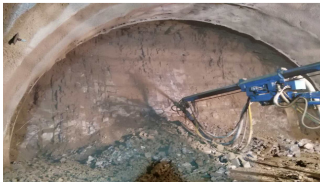
Slika 3 : Postupak nanošenja mlaznog betona 3
