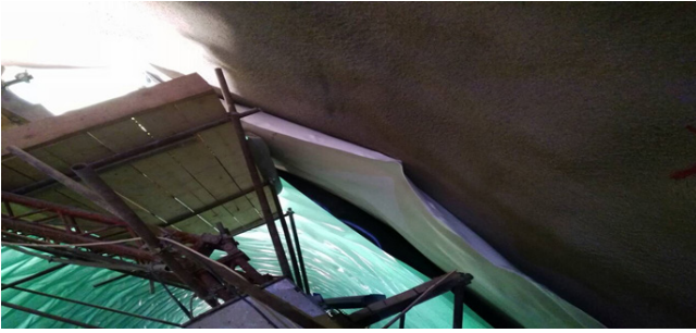
Slika 10: Geotekstil na tunelu
