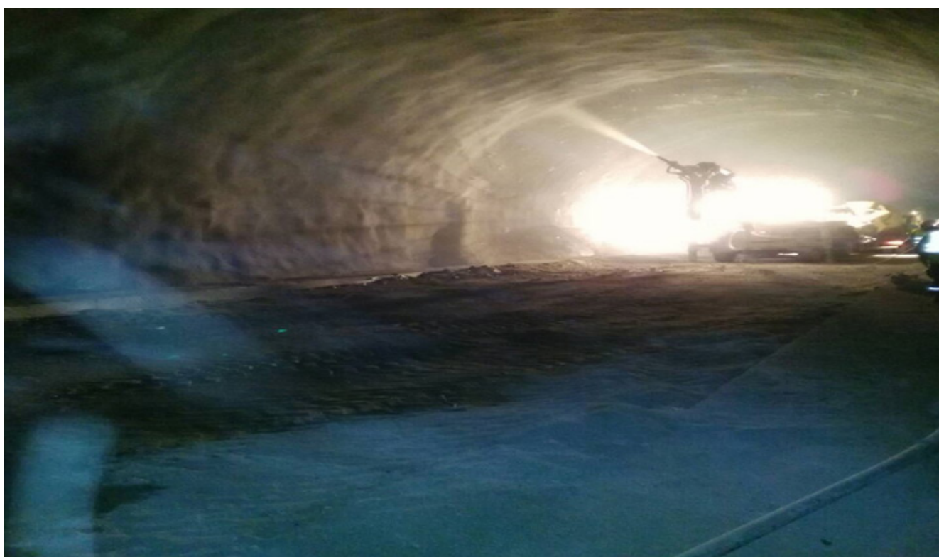
Slika 9: Nanošenje mlaznog betona
