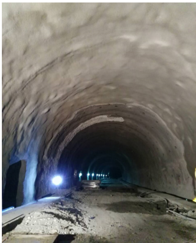
Slika 7. i 8. Freziranje sidara i nanošenje mlaznog betona 6
