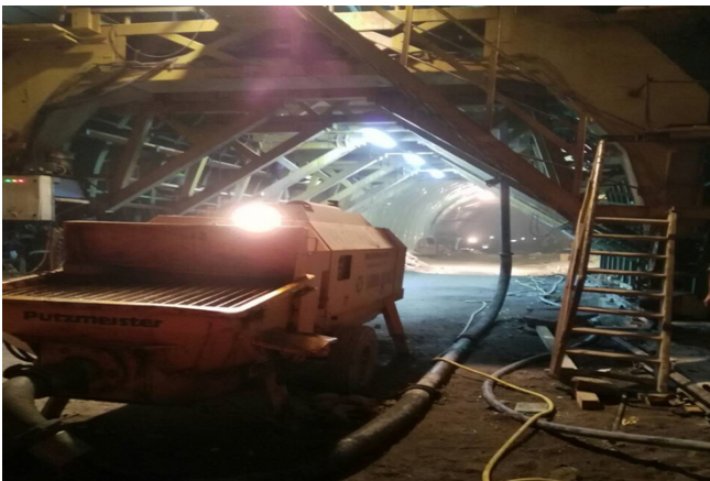
Slika 21. Postavljanje oplata i betoniranje u tunelu Pečuj
