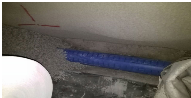
Slika 18: Zatrpavanje drenažne cijevi suhim betonom
