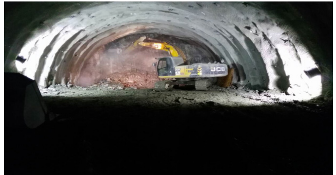
Slika 1: Iskop na čelu pomoću udarnog čekića 1
