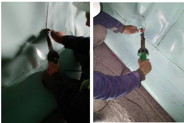
Slika 13. i 14. Krpljenje fleka koje su nastale isijecanjem ili oštećenjem hidroizolacije
