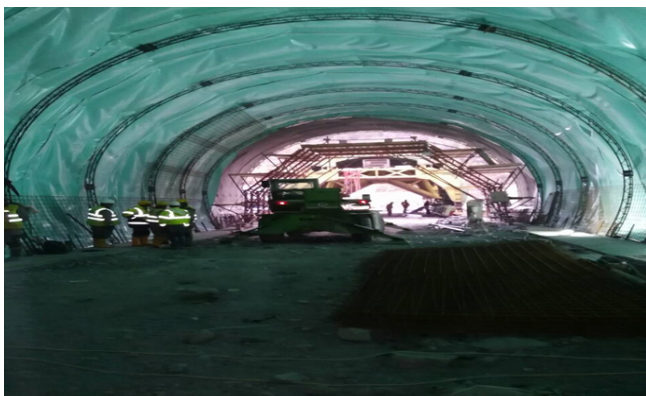
Slika 15: Postavljanje armature u tunelu
