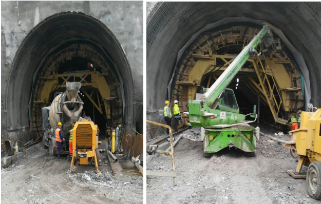
Slika 19. i 20. Postavljanje oplata i betoniranje tunela Pečuj 9
