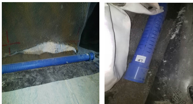
Slika 16. i 17. Postavljanje drenažne cijevi u tunelu
